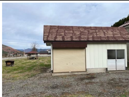
車庫兼用倉庫、庭と東屋
