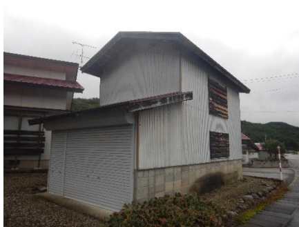
車庫兼用倉庫
