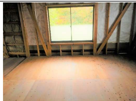
2階 内装未完成
