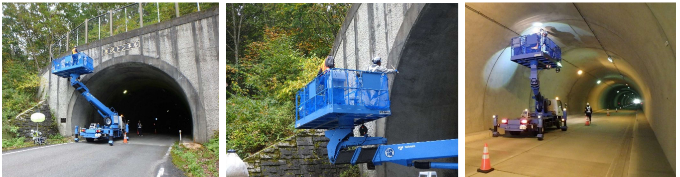
写真 3.2 トンネル定期点検の様子
