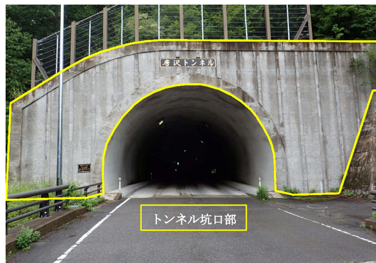
写真 4.1 トンネル坑口部の点検対象箇所
