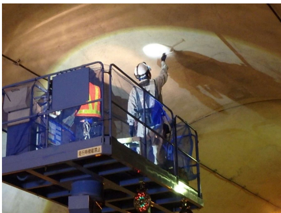
写真 4.4 打音検査
