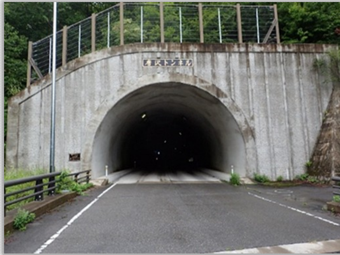
唐沢トンネル
