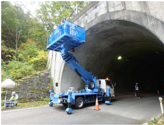
写真 4.2 高所作業車による点検
