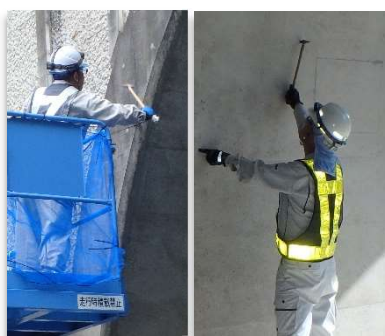
<打音検査状況>
