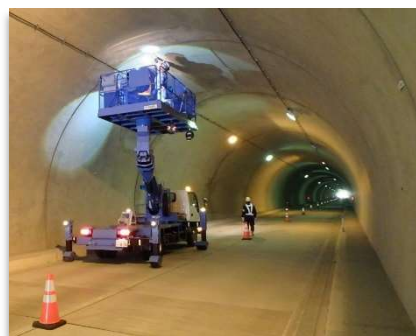
<トンネル点検車による点検状況>
