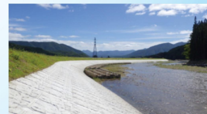
松沢川河川災害復旧助成工事（護岸工）
