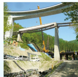
銀竜橋撤去工事（中山峠）
