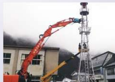
解体作業の様子
