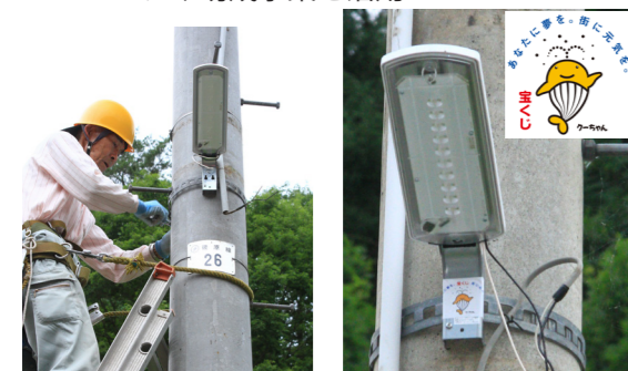
改修された防犯灯
