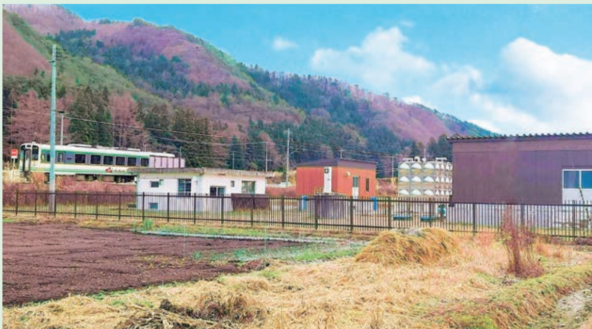
田島第1水源地
