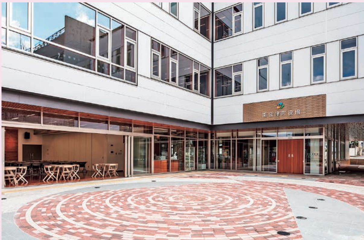
南会津町役場本庁舎
