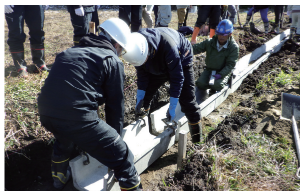
竹筋コンクリート製U字溝を設置する様子
