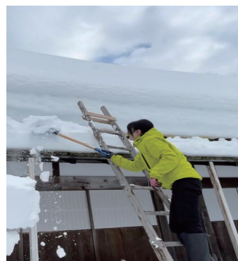
古民家の雪下ろし
