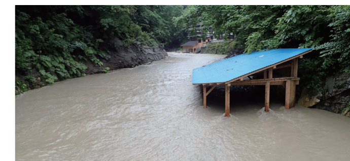
木賊温泉共同浴場への土砂流入(令和3年8月)
