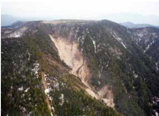
田代山山腹の崩落状況（南会津建設事務所提供）
