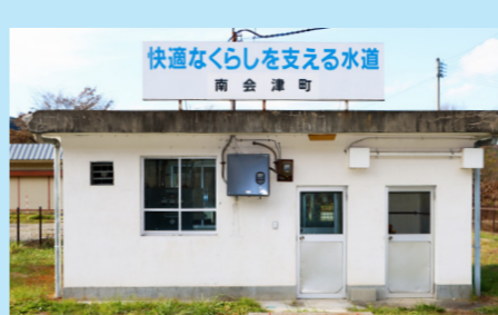
施工前(田島第一水源 送水ポンプ場)
