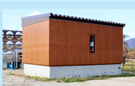
施工後(田島第一水源 送水ポンプ場)
