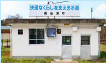
施工前（田島第一水源 送水ポンプ場）
