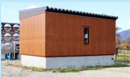
施工後（田島第一水源 送水ポンプ場）
