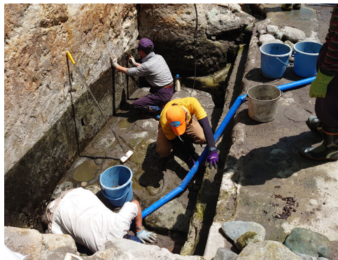
岩風呂復旧作業の様子
