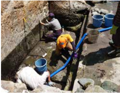
岩風呂復旧作業の様子
