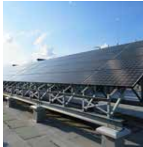
町役場本庁舎太陽光パネル
