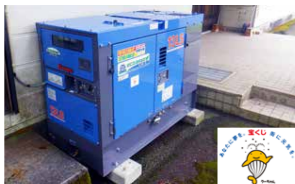
設置された発電機(永田林業研修センター)
