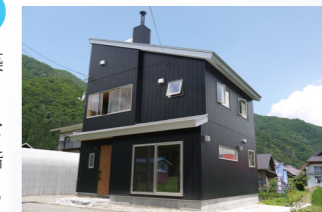
一般住宅 外観
