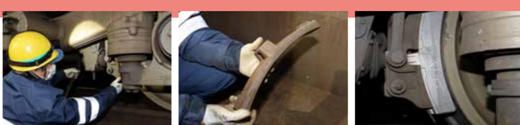
写真③ 3枚 ブレーキ装置の摩耗した部品を交換 (作業手順: 左から)
