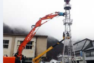
解体作業の様子
