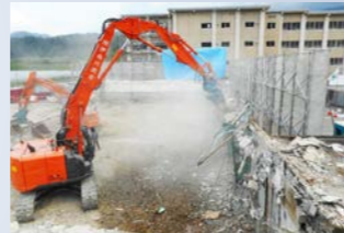
南会津高等学校旧体育館解体の様子
