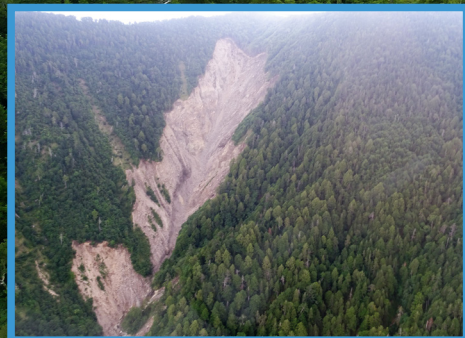
ヘリから見た田代山のり面の崩落現場
