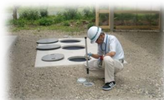
上・下水道整備事業 (生活排水対策)
