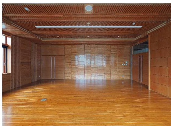
2階 町長室 (床・北面壁)
