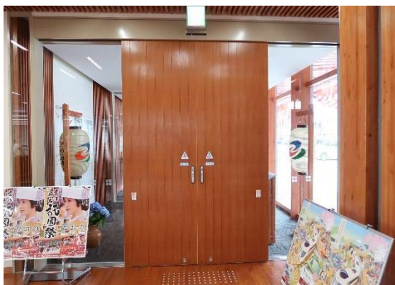
風除室（室内側自動ドア）
