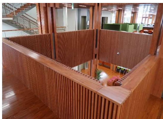
吹抜手摺天板
