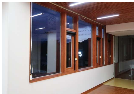
1~3階 外壁面の窓枠
