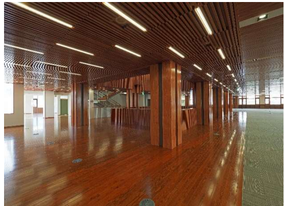
2階 吹抜け廻り（天井）
