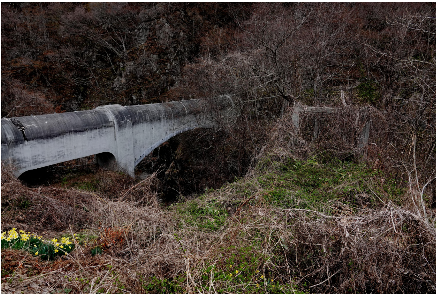
宇都宮街道の弥五島宿から松川宿に行く途中、大川を渡る橋が架かっていた場所(推定) この場所は、大川が狭くなっていて、旧121号線に架かる橋の遺構が写っている。後方には、 旭田ダムで取水され湯野上発電所に送られる導水管が写る。
