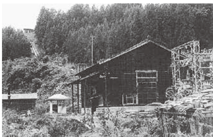
旧針生発電所
