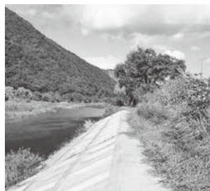
阿賀川田部原地内の堤防状況
