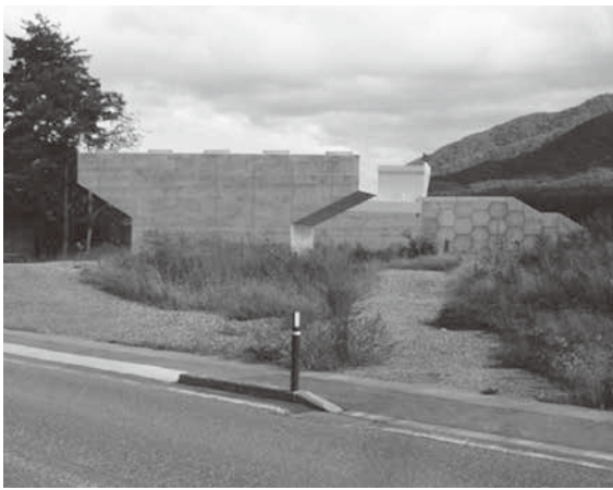
長野地内の工事現場 (会津鉄道と県道の橋梁架設工事)
