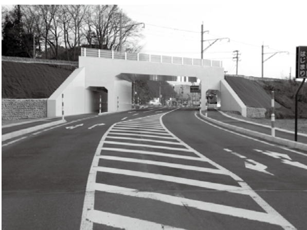
完成した鎌倉崎・松下線「跨道橋」
