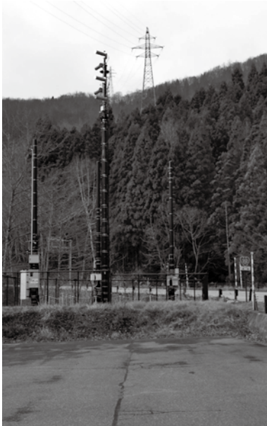
中山峠 銀竜橋付近の電波塔
