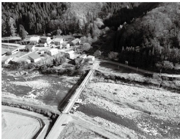
上空から見た青柳橋周辺
