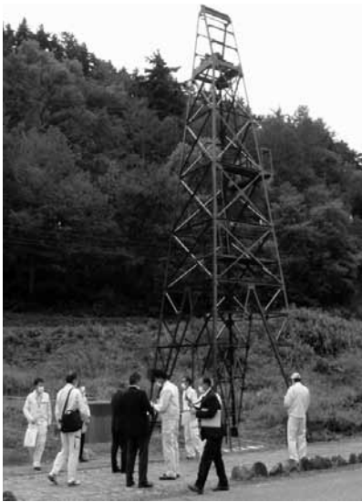
揚湯管の現地調査
