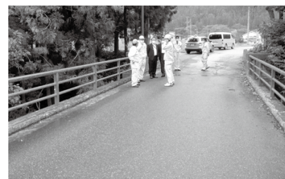
撤去される「旧南郷橋」
