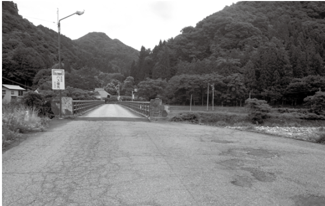
青柳橋の現状（青柳地区）
