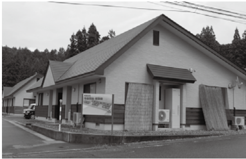
町営住宅（寺前地区）
