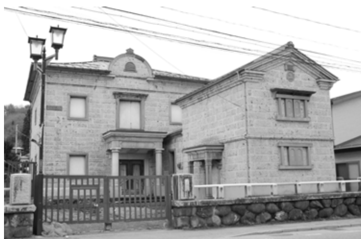
中心市街地の石造りの建築物（田島上町地内）
