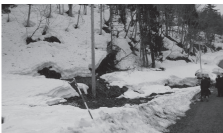
崩落箇所を視察する産業建設委員会
