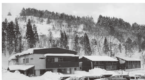
南郷スキー場に隣接する建設中の宿泊棟
