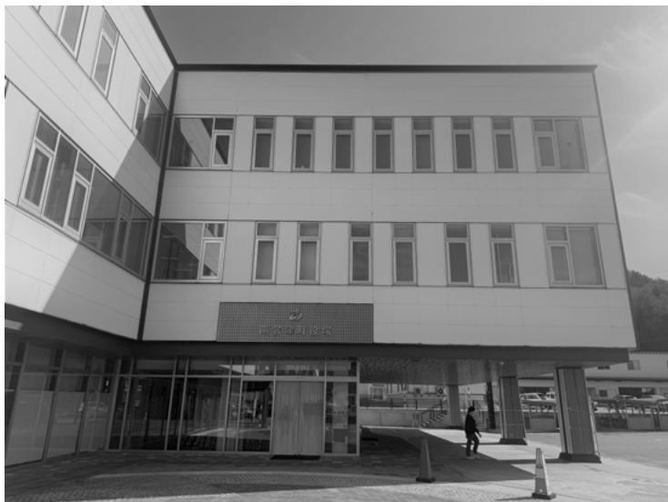
南会津町役場本庁舎
