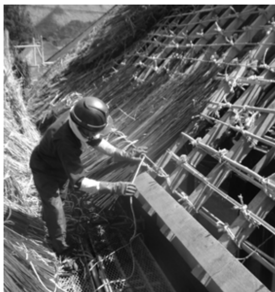
茅葺屋根の修繕
