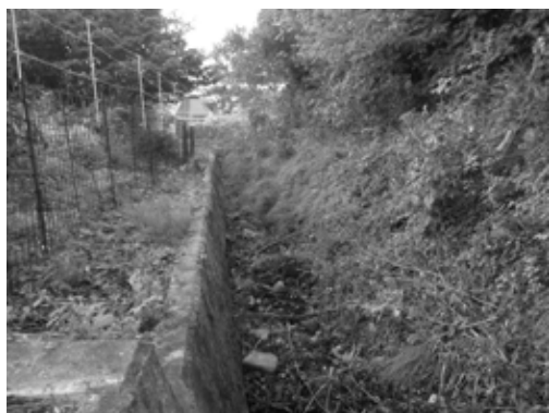
山法面の様子
