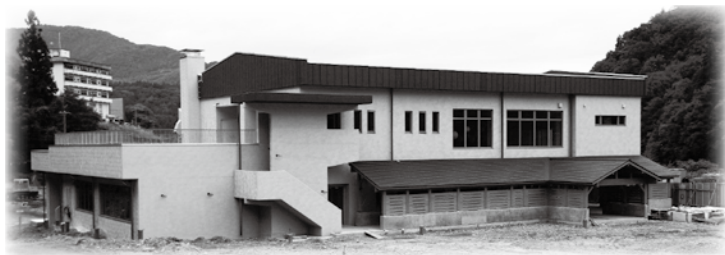
完成した新さゆり荘パブリック棟（左奥が、現さゆり荘）
