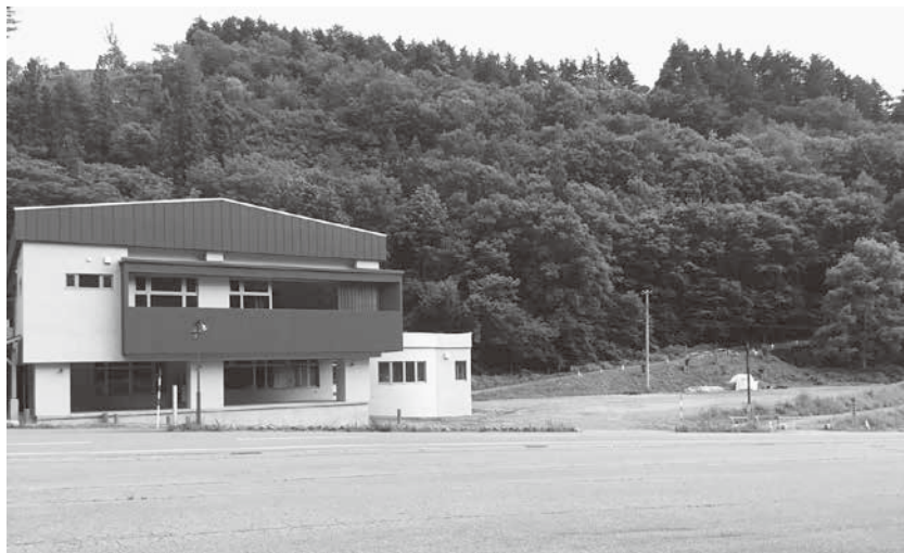
さゆり荘宿泊棟建設地
