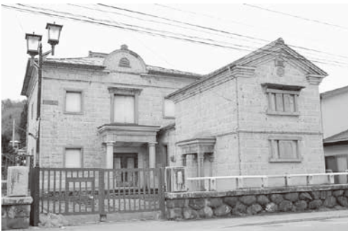
利活用が検討されている石造り建築物 (田島上町地内)
