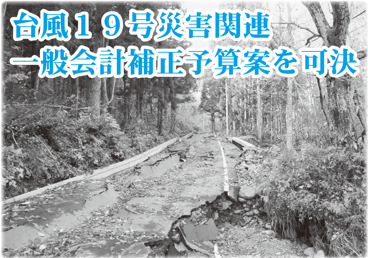
町道東106号線（旧駒止峠）の被災のようす
