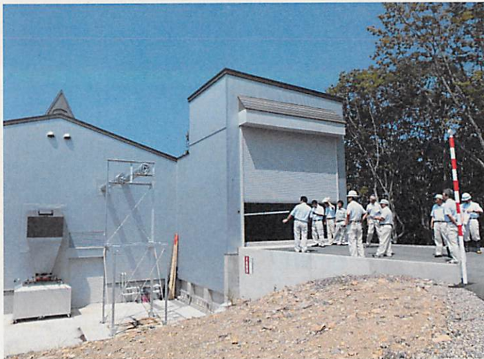
チップボイラー施設 高杖地区
