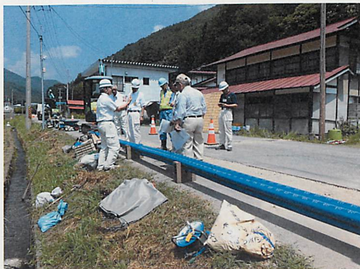
水道配水設備拡張事業 帯沢地区
