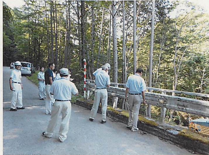
向山1号線（橋梁下部工）木賊地区
