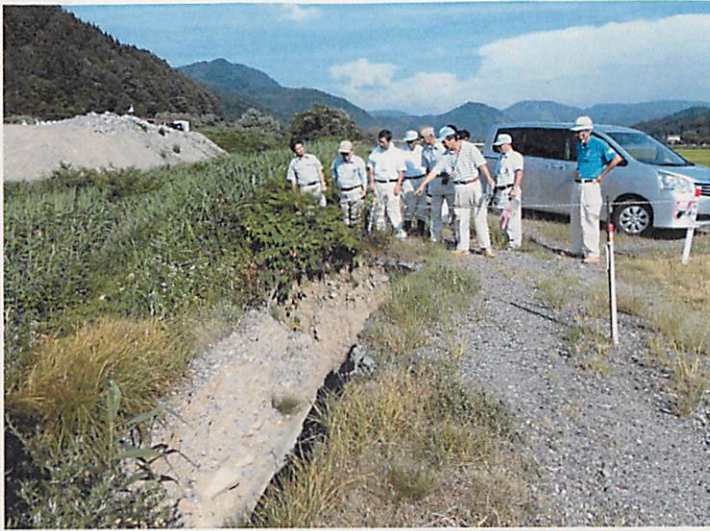
和泉田沢河川復旧工事 上平地区
