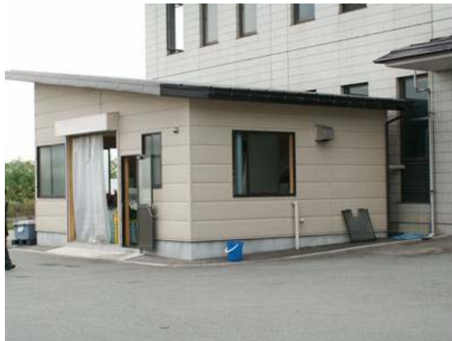
写真 3.2 クリーンピア共立廃食用油燃料化施設
