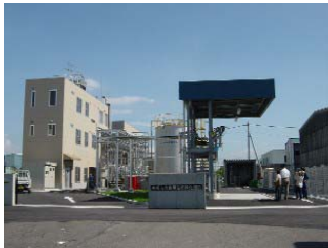
写真 3.1 京都市廃食用油燃料化施設
