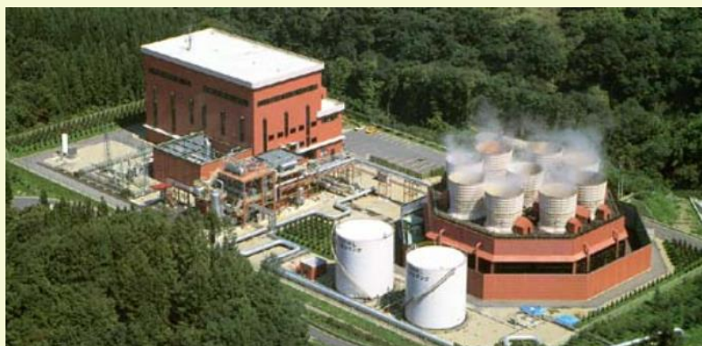
柳津西山地熱発電所(福島県柳津町)
