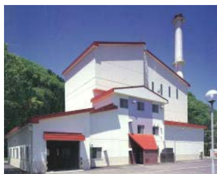
西部クリーンセンター (南会津地方環境衛生組合)
