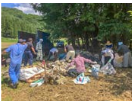
不法投棄物撤去作業
