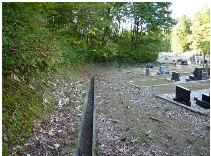
＜排水溝の状況＞
