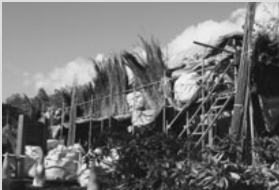
※写真は工事中のものです。
