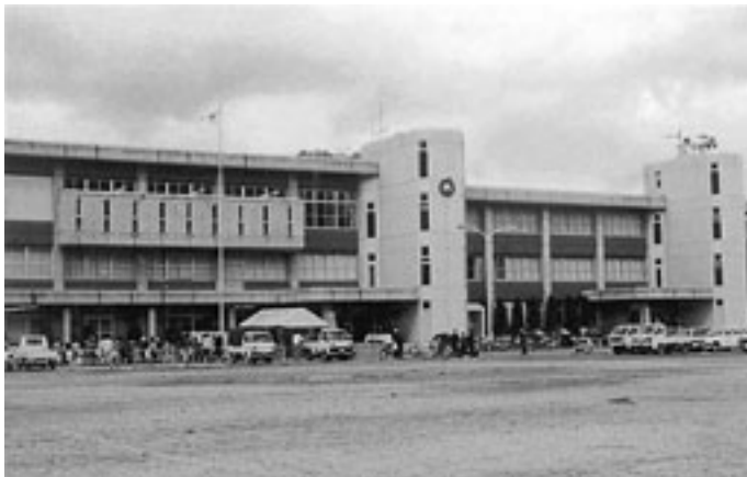
【伊南総合支所庁舎写真】
