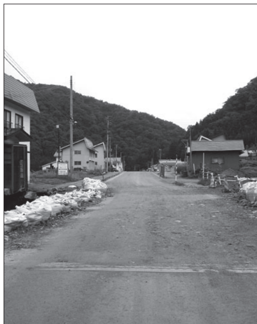
土石流により流されてしまった小立岩地内の国道352号（表紙写真）も仮復旧し、町内の国・県道の通行止めはすべて解除され、小立岩、大桃地区の孤立は解消された
