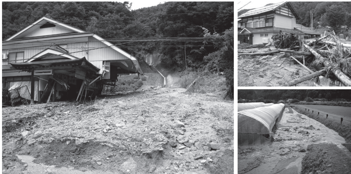
写真：土石流により甚大な被害を受けた家屋や農地。人的な被害がなかったことが信じられないほどの惨状だった
