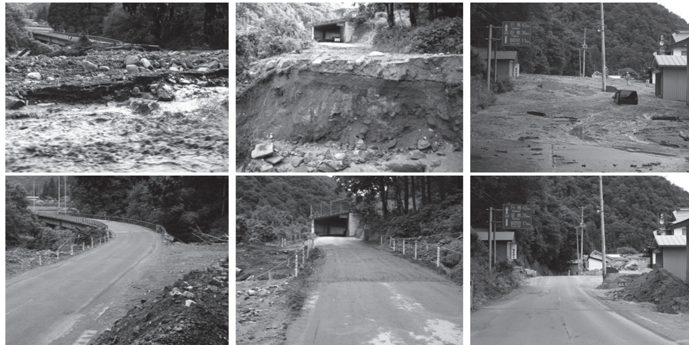
写真上：災害直後の国道352号と401号。大量の土砂が堆積したり道路が流されたり大きな爪跡を残した 写真下：復旧作業後の様子。懸命な復旧作業により早期に道路が仮復旧し、上流の集落の孤立は解消された（すべて内川地内）
