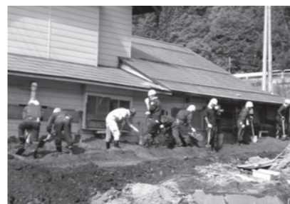
内川地内で土砂撤去作業を行う消防団員
