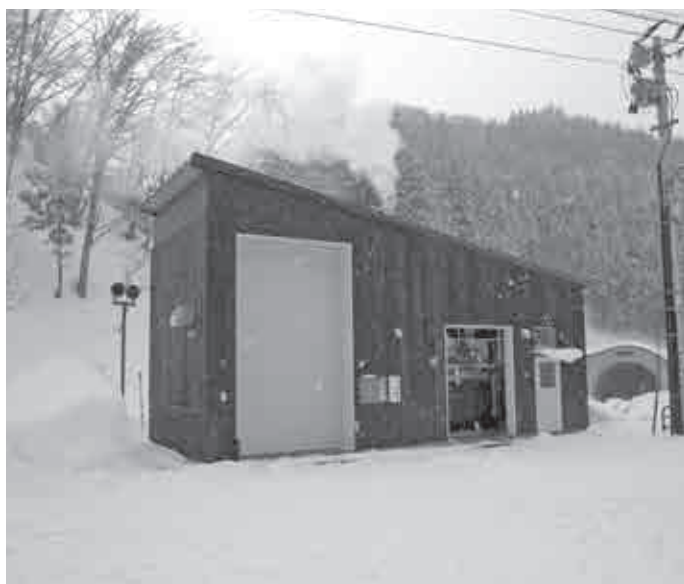
間伐材を燃料にする木質バイオマスボイラー（きらら289）
