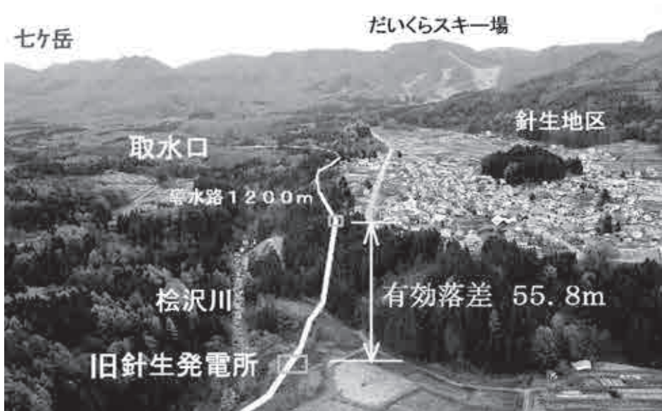
旧針生発電所の状況
