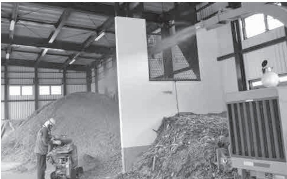
チップ生産保管施設（青柳地区）
