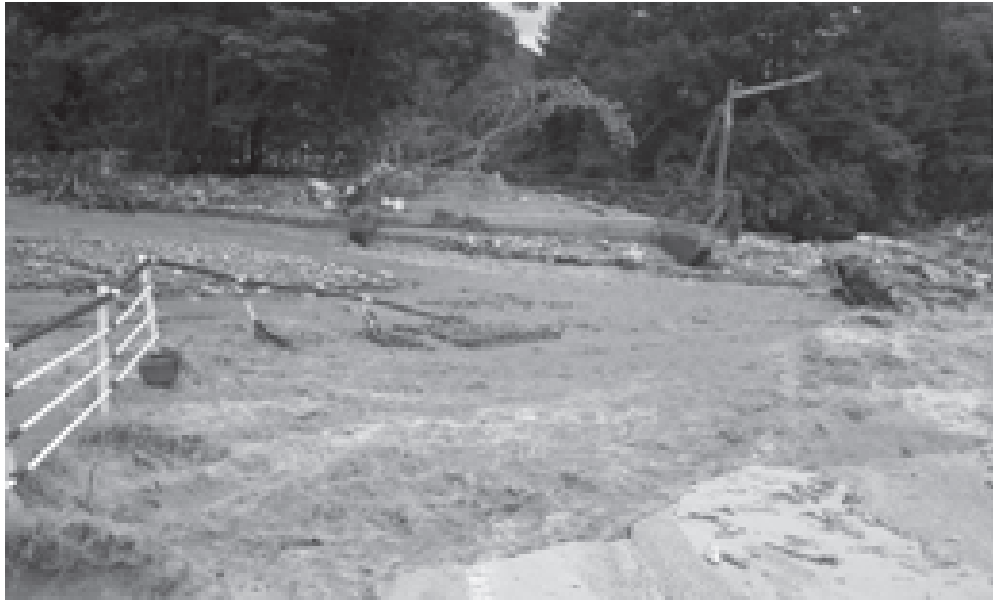
土石流により寸断された国道352号（小立岩地内）
