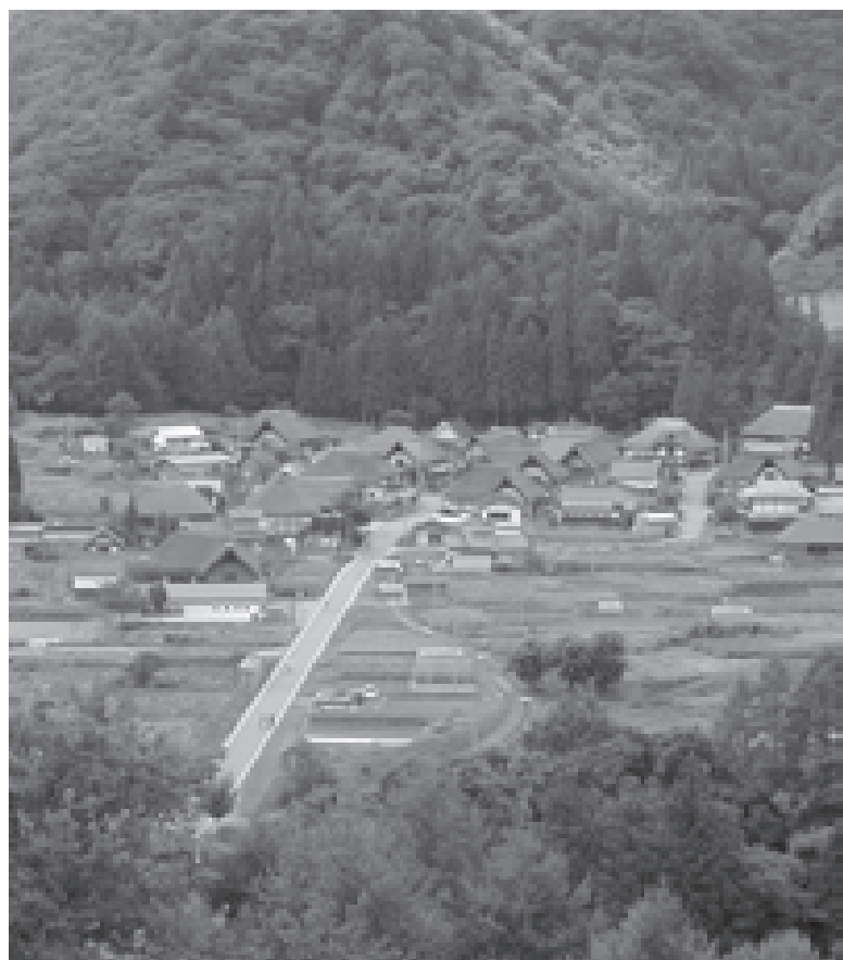
地区住民の生活を守りながら周辺環境整備を進める前沢伝統的建造物群保存地区
