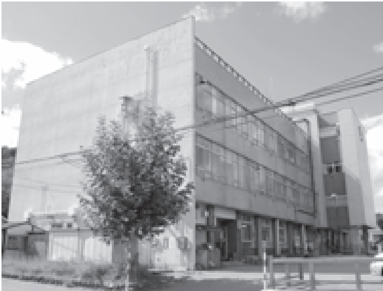
昭和41年に建設され老朽化が進む役場本庁舎
