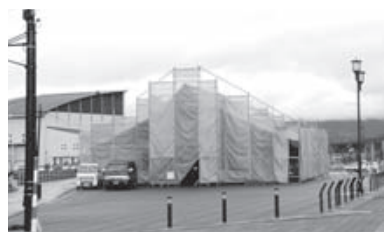
田島地域宮本地区に建設中の 「町の駅」
