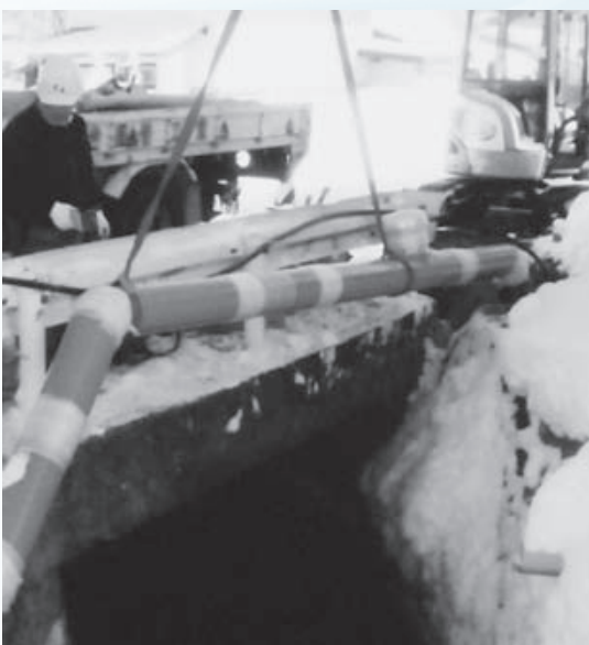
給配水管布設替工事
