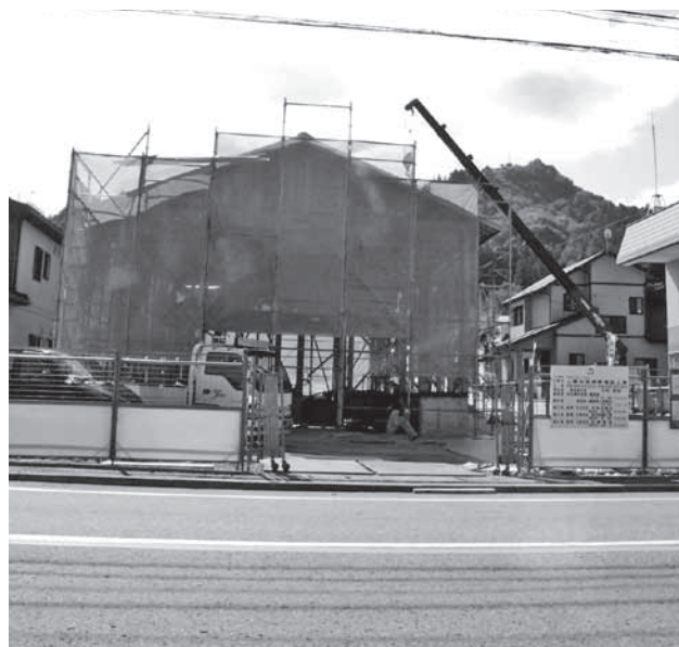
商店街に建設中の屋台格納庫
